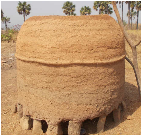
ąą - grenier (en construction)
